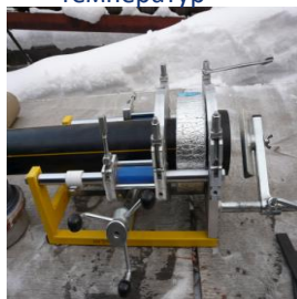
4. Охлаждение сварного соединения в теплоизоляционной камере
