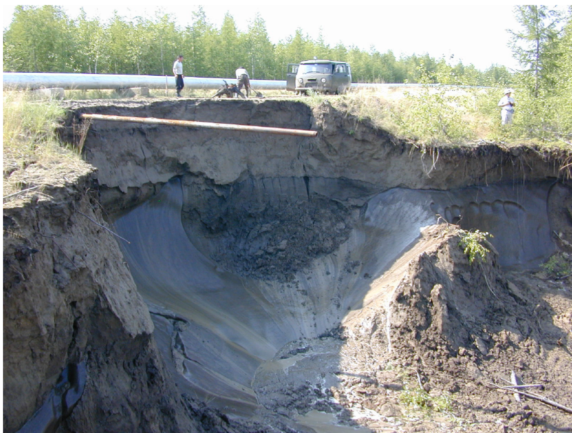
Рис. 35. Исследования ледового комплекса на участке железнодорожной трассы Беркакит—Томмот—Якутск.
