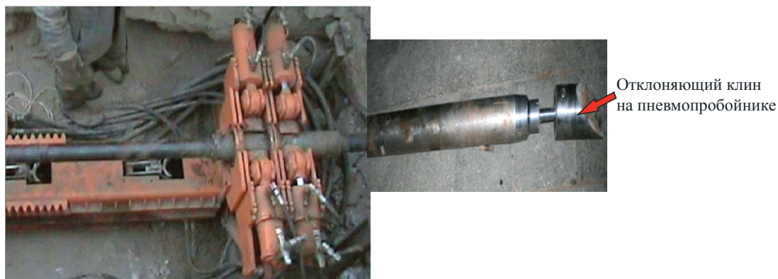
Рис. 23. Буровая установка с пневмоударным механизмом.
