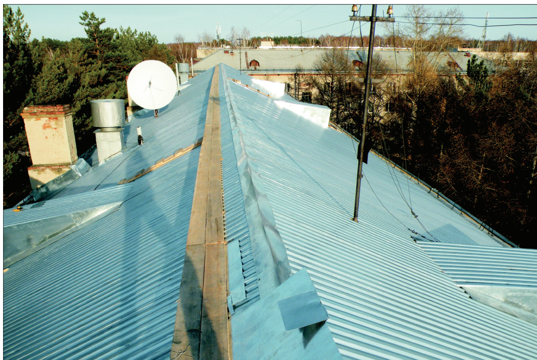
Рис. 16. Ремонт кровли жилого дома с заменой шифера на оцинкованный профилированный лист (ННЦ СО РАН)
